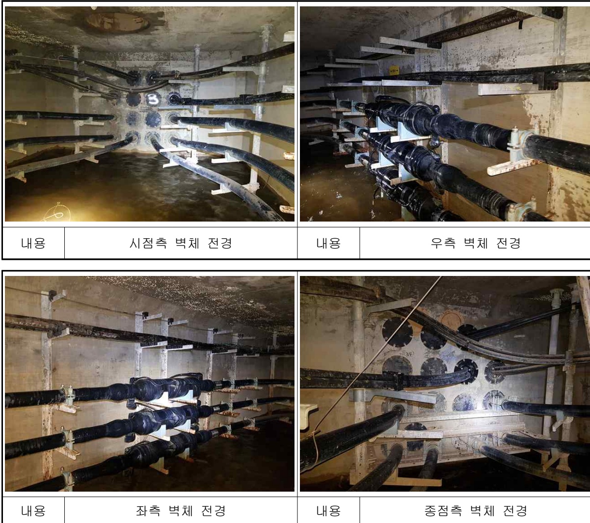
【사진 7.13】 문발~운정#4 전경
