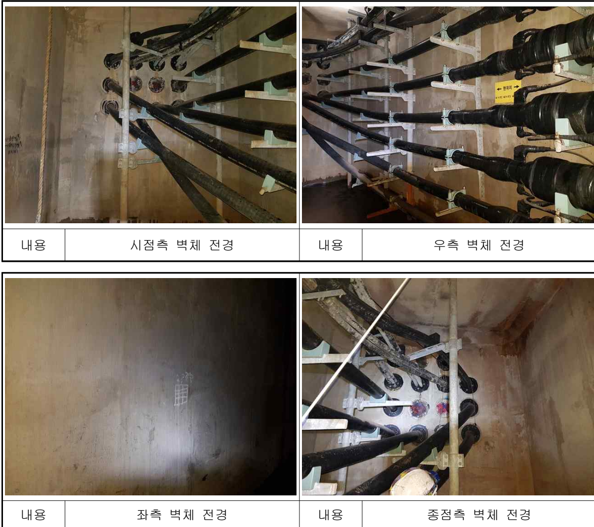
【사진 7.57】 문발~운정#13 전경
