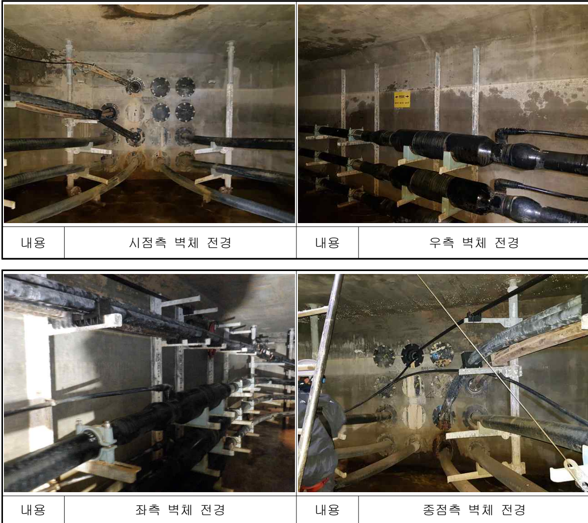
【사진 7.21】 문발~운정#6 전경
