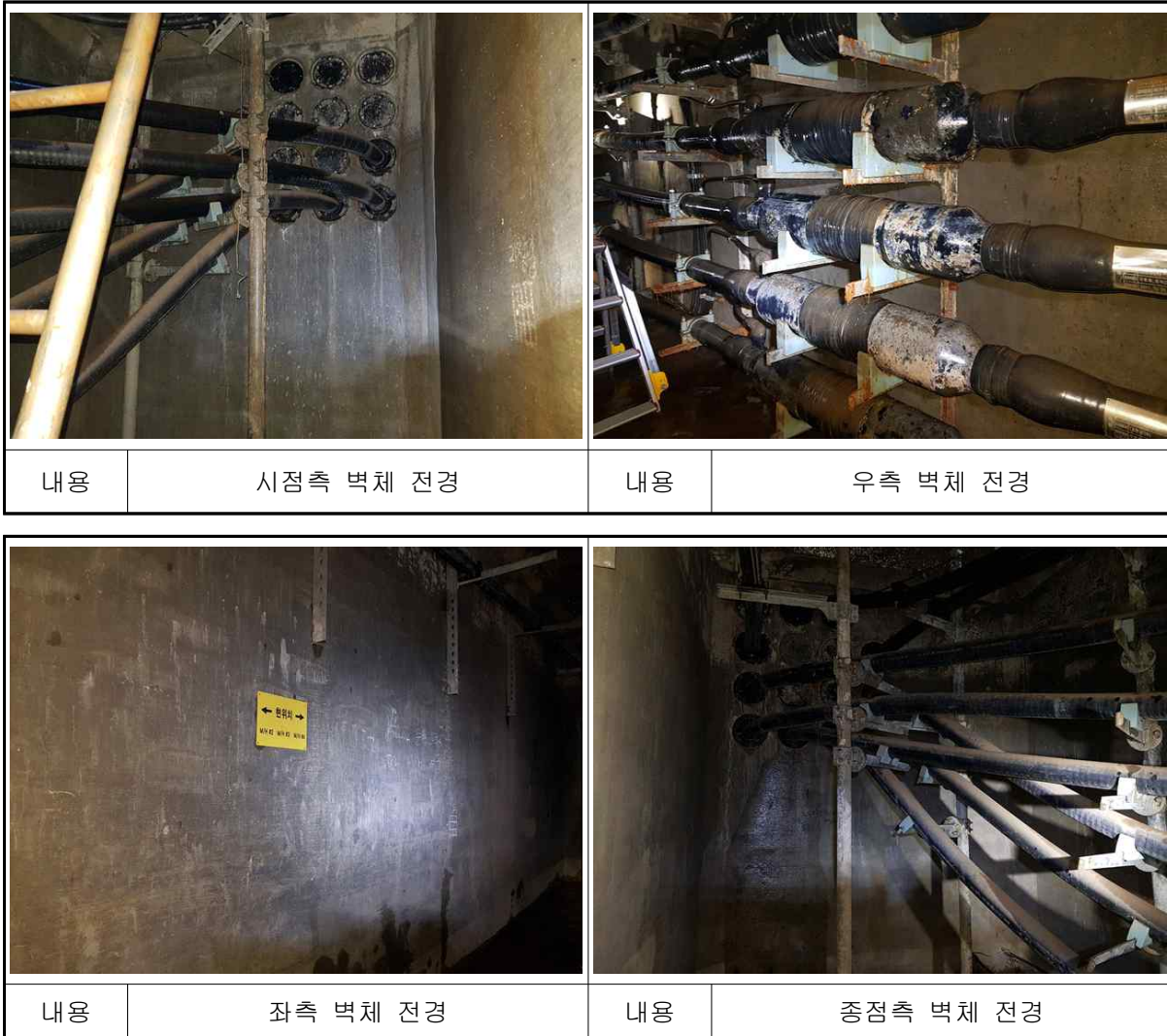
【사진 7.9】 문발~운정#3 전경
