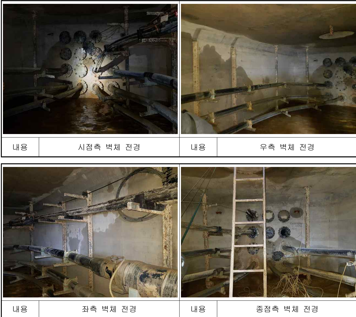
【사진 7.17】 문발~운정#3 전경
