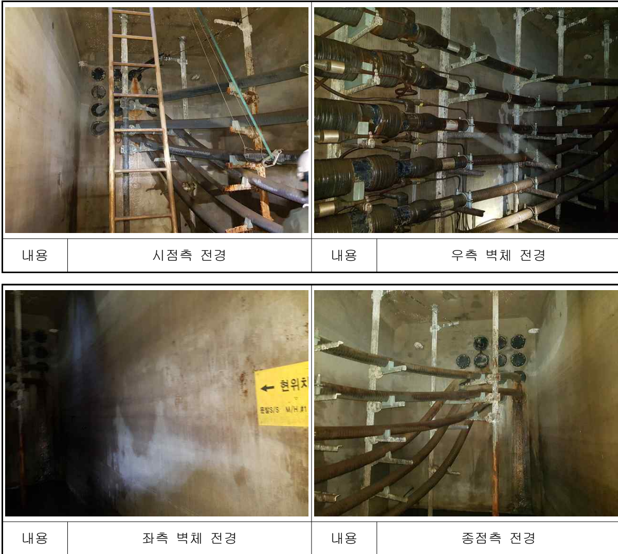
【사진 7.1】 문발~운정 #1 전경
