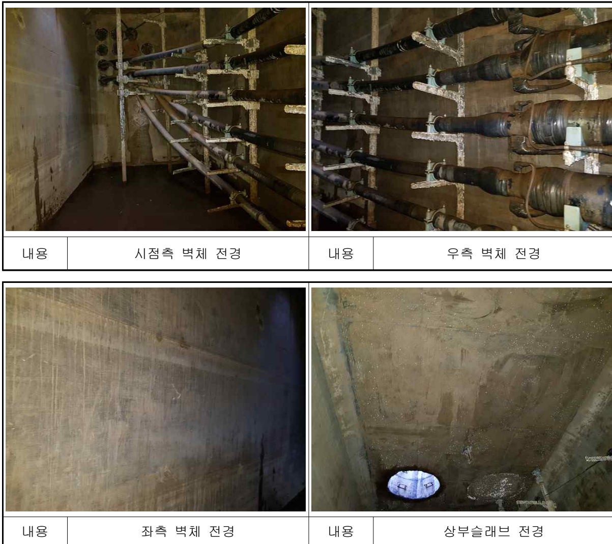
【사진 7.5】 문발~운정 #2 전경
