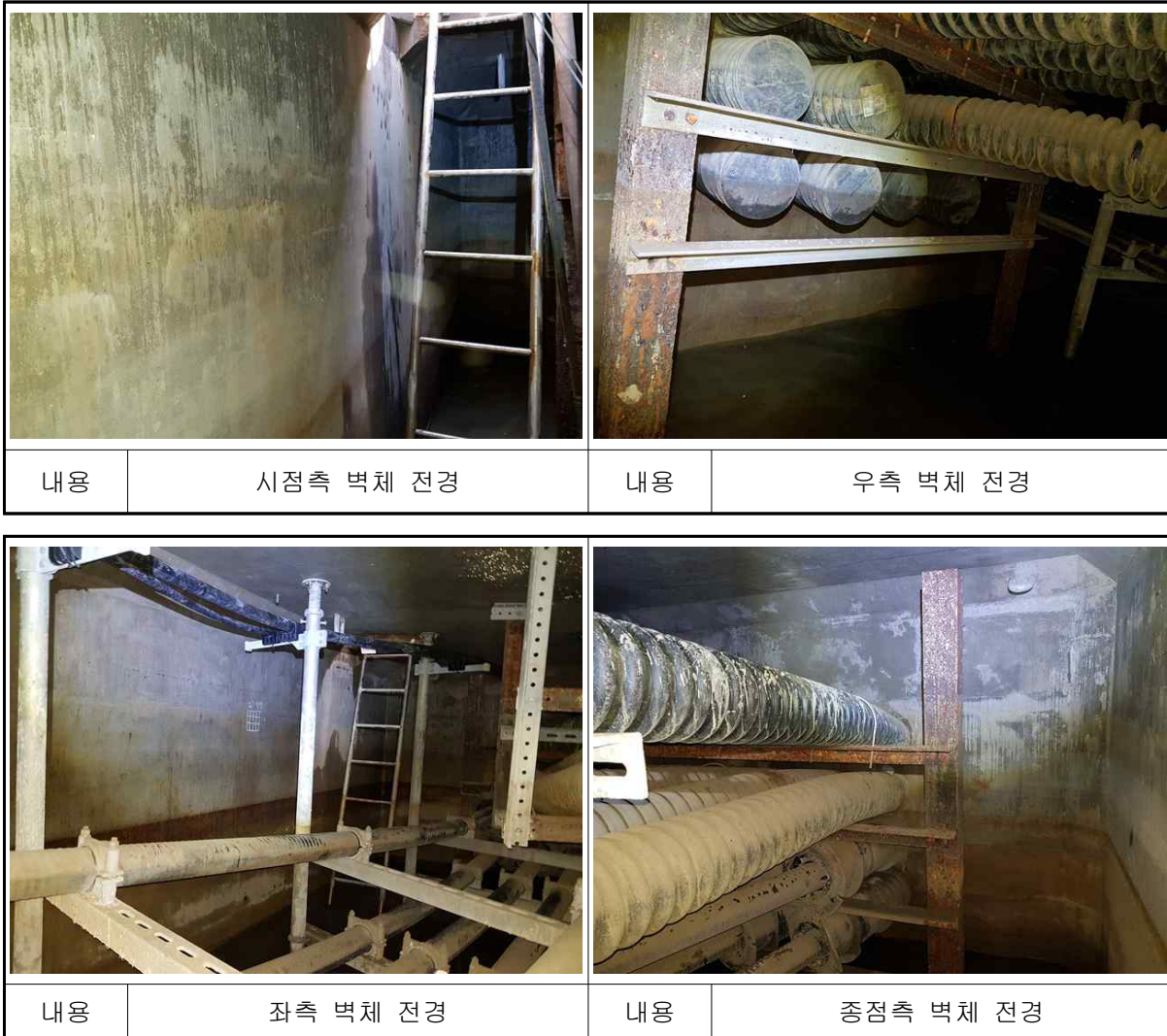
【사진 7.29】 문발~운정 #7-1 전경
